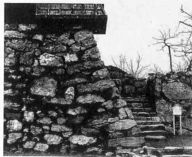
写真四 現存する天守台石垣と東付櫓の石垣(部分) 一九六〇(昭和三五)年一月に撮影されたものです。石垣角の算木積みみのようすがよくわかります。
