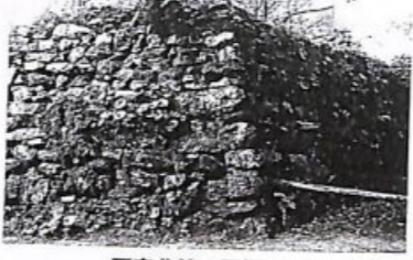
天守曲輪の石垣 天守曲輪を囲む堤防状の石垣で、江戸時代には上に土堀が掛けられていた。横矢掘り(側面射撃)のために複雑に屈曲する。
